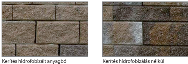
Kerítés hidrofobizált anyagból
